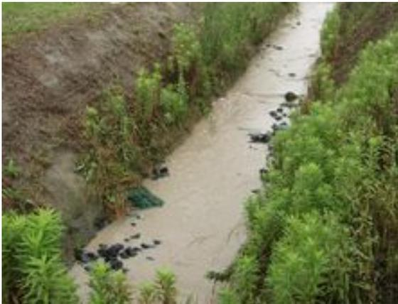
農水省は排水の浄化対策として、中央干拓地排水路に浄水場発生土を敷き詰めてリンを吸収させようとしている。これは、浄水過程で発生するアルミ成分を含んだ廃土のリン吸着能力を利用したものとされている。しかし、現実には、浄水場発生土の多くは排水と一緒に流されてしまい、干拓地の排水は僅かに残った浄水場発生土の上方を素通りして、濾過されないまま調整池に流れ込んでおり、農水省が実施する浄化対策には疑問が残ると言わざるを得ない。(左写真の黒い塊が浄水場発生土)
